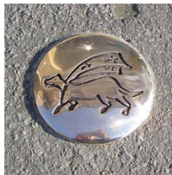
Auray (56) Clou de jalonnement en fonte de bronze Format : Ø 150 mm
