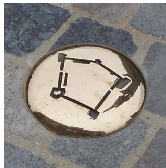
Landrecies (59) Clou de jalonnement en fonte de bronze Format : Ø 150 mm
